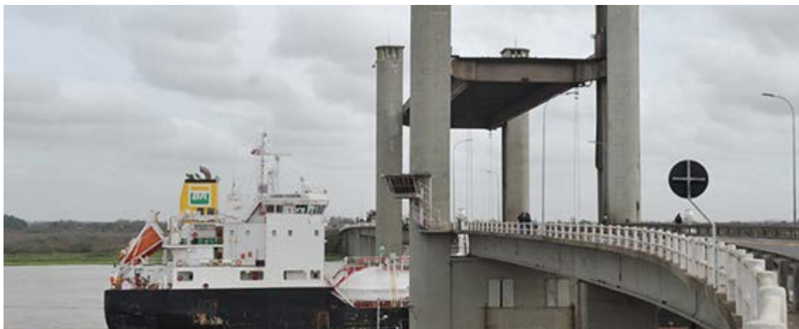
Figura 2: Ponte do Guaíba içada.
