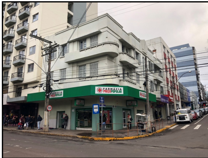
Figura 8. Vista da fachada do Edifício Lângaro, localizado na esquina da Av. General Netto com a Av. Brasil. Foto: Da autora, 2018.
