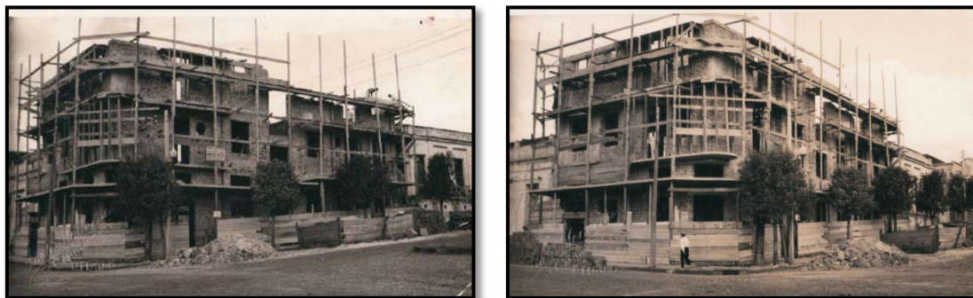
Figura 5 – Fotos da construção do Edifício Lângaro, em 1942. Foto: Acervo Fernando Canali Lângaro.
