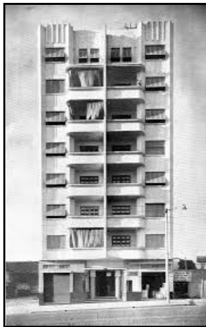
Figura 4. Fachada do Edifício Gonçalves Biar, São Paulo. Projetado por Tadeu Giuzio. Neste edifício, podemos perceber claramente as características do Art Déco, na simetria da fachada, coroamento com elementos decorativos geométricos e sacadas curvas. Fonte: PINHEIRO, 2008, p. 113.
