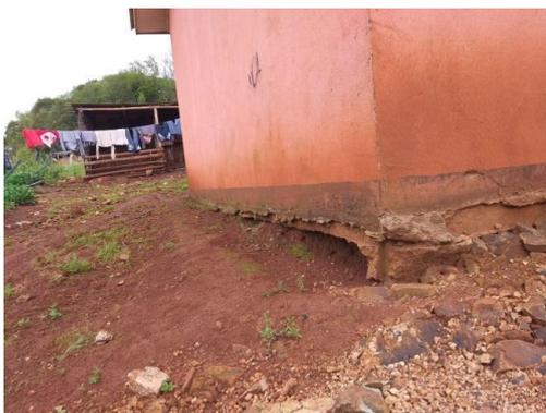
Figura 15: Problemas estruturais na fundação da residência.
