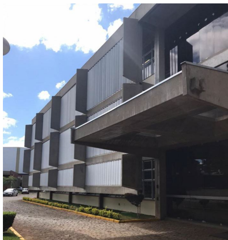
Figura 7: Centro Administrativo Grazziotin, obra com o uso de concreto aparente e características brutalistas. Fonte: Autora (2020)
